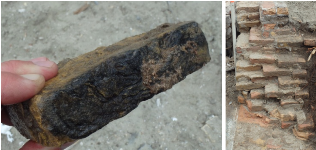
Afb. 13. Roetaanslag op baksteen uit onderste laag fundering.
